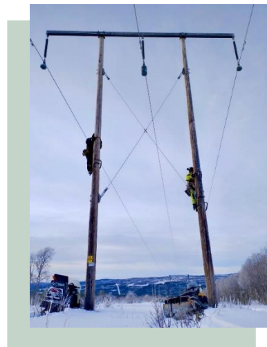
Montering på Røros. Foto: Gridguard
