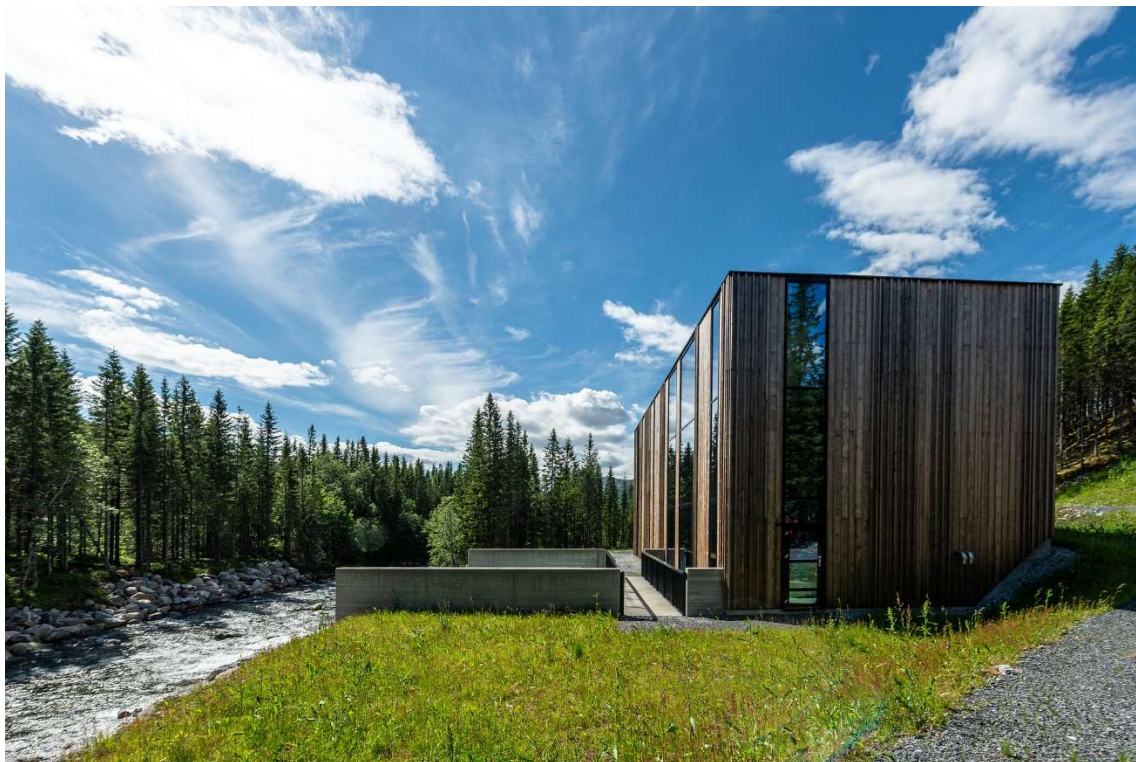
Figur 1 Tverråa kraftverk i Brønnøy kommune, som ble satt i drift i 2018 som en del av Tosbotn-utbyggingen. Foto: Helgeland Kraft Vannkraft
