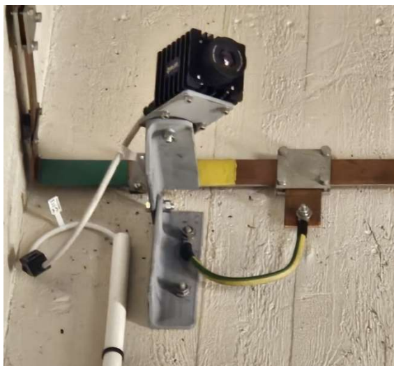
Figur 8. Forbedret montasjebrakett til varmekamera
