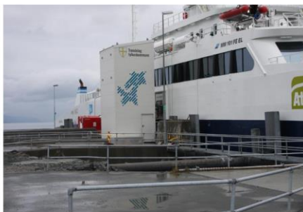
MF Logatun legger til ved ladetårnet på ferjetaket på Flåsk. Foto: Karl-Henrik Linder
